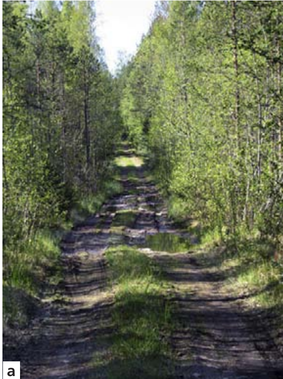
Kuva 36 a ja b. Seitsemänlamminsuolla Hämeenlinnan Rengossa poistettavalla tiellä oli suon kohdalla hiekan sekaista soraa (a). Soraa nostettiin takaisin kivennäismaalle ja siitä muotoiltiin tien alkuun kumpare estämään poistetun tien käyttö (b). Tielinjaa maisemoitiin tielle nostetuilla kuusen ja lepän taimilla, jotka juurtuivat siirtopaikoilleen. Kuvat: Helena Lundén.
