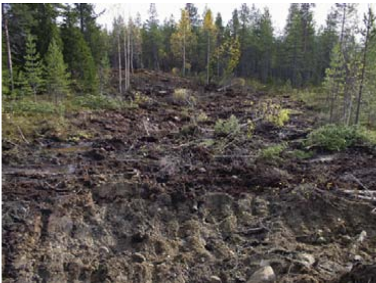
Kuva 37. Rautavaaran Pumpulikirkolla suon ylittävälle tien osalle oli siirretty soraa kangasmetsäsaarekkeista. Tien poistamisen yhteydessä sorat siirrettiin kaivinkoneella takaisin kivennäismaalle. Metsäsaarekkeiden tieleikkaukset täytettiin soralla myötäilemään maanpinnan muotoja. Kuva: Suvu Haapalehto.
